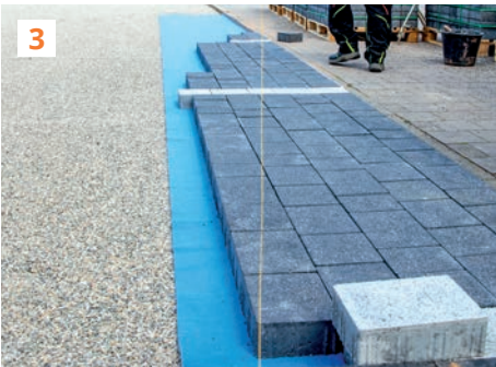
Die Pflastersteine werden wie gewohnt, nach bekannten Regeln, verarbeitet.
