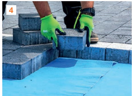
Wichtig ist ein Überlappen benachbarter Aquatextilbahnen.
