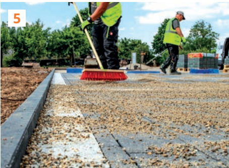
Das Fugenmaterial wird eingebracht. Anschließend erfolgt die Verdichtung.
