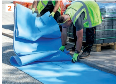
Die erste Bahn wird am Rand angelegt und ausgebreitet.
